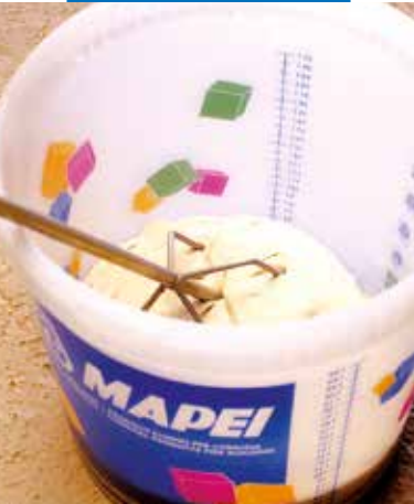
Mezcla de Mapeset C1 con agitador mecánico
