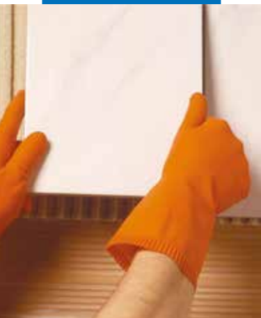
Colocación en pared de revestimiento cerámico
