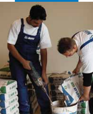
Mezcla de Ultraplan Eco - Asilo Mirabello de Cantù - Italia
