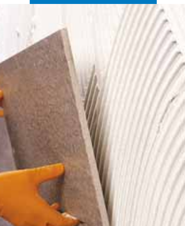
Colocación de baldosa de bicocción de gran formato en pared de arriba hacia abajo
