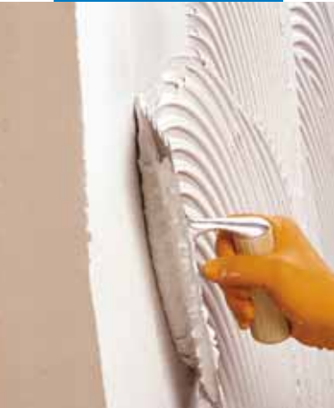
Aplicación de Tixobond White sobre soporte
